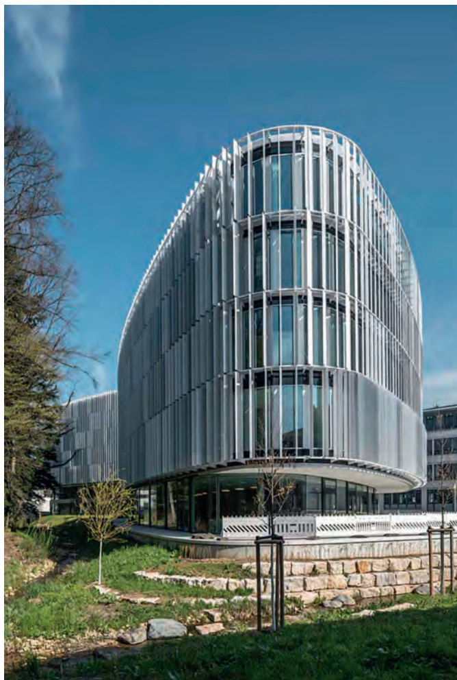
Bild 1. Kundenzentrum der Robert Bosch Automotive Steering GmbH in Schwäbisch Gmünd: Außenansicht mit beweglichen Shadometal-Lamellen
