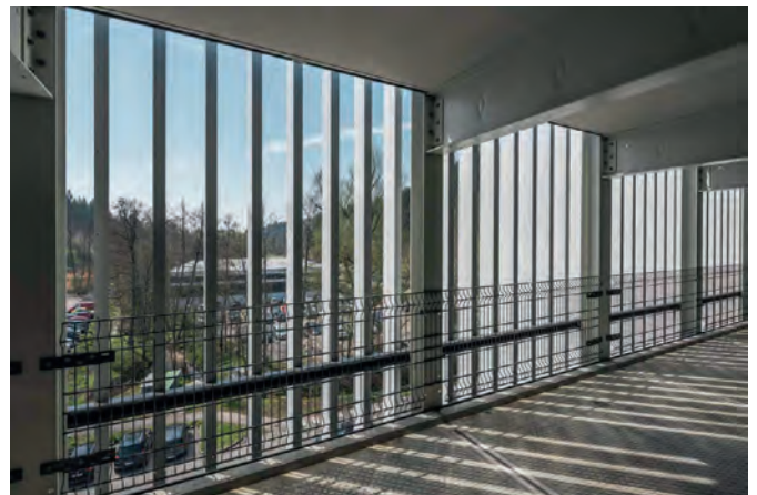
Bild 6. Parkhaus: Innenansicht mit Shadometal-Lamellen (Fotos: Lars Gruber/Colt International GmbH)
