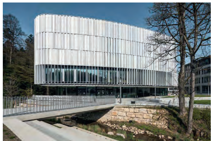
Bild 2. Die Klimatisierung der Gebäude und der Lichteinfall werden über die Fassade gesteuert
